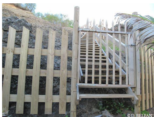
Îlet de Sainte-Marie : dispositif de prévention d'accès (vu de face)
