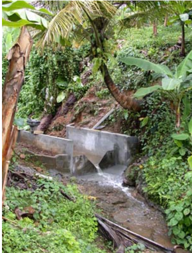
Photo 5 : déversoir pour la mesure des débits à l'exutoire du bassin
