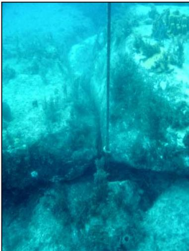
Figure 3- Mouillage avec piton
