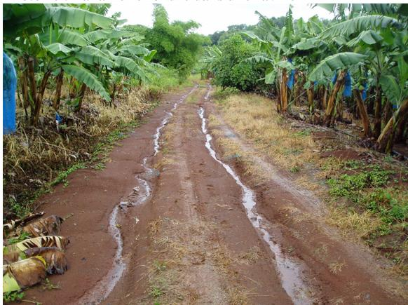
**Photo 18 : Trace en terre avec érosion dans les passages de roue**
